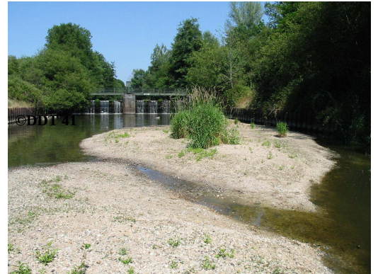
Atterrissement formé à l'aval de la fosse de dissipation d'énergie d'un seuil.
