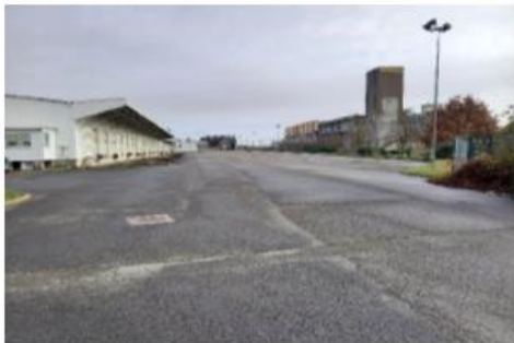
Vue sur la partie sud du site
