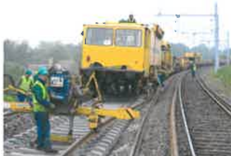
Longs Rails soudés sur traverses béton
