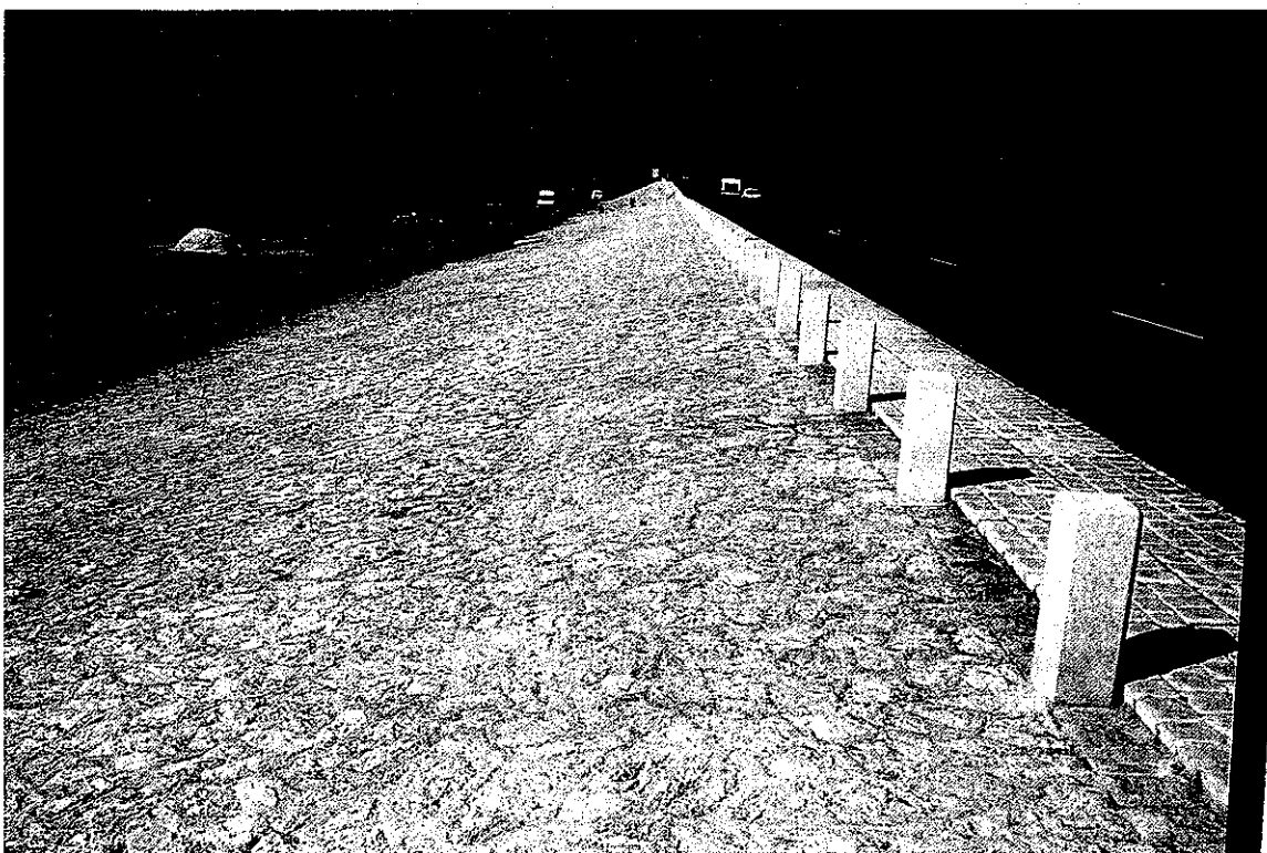
Déversoir de Montlivault
