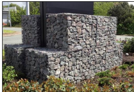
Figure 8 : Exemple de muret en gabion (Source : TCS Geotechnics)
