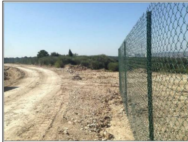
Figure 13 : Illustration d'une clôture d'une centrale photovoltaïque URBASOLAR (Source : URBA 378)
