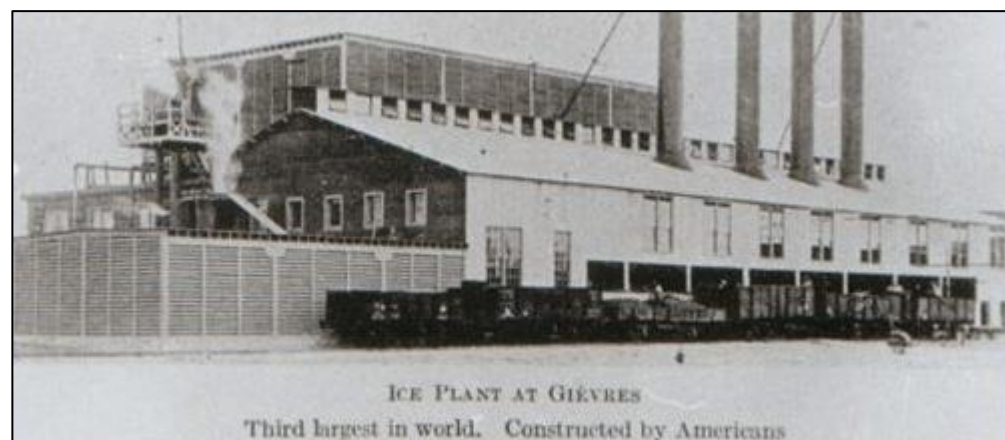
Photographie de l'usine frigorifique anciennement présente sur le camp américain de Gièvres. Source : Mairie de Gièvres
