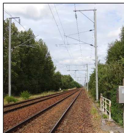
Voie ferrée au Nord du site d'étude
