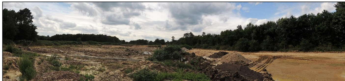
Partie de la Carrière LANDRE en cours de réaménagement correspondant à l'Ouest du site d'étude Source : L'Artifex 2017
