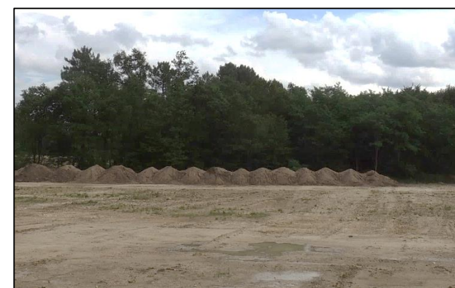
Apport de terre végétale (actuellement stockée fond de parcelle) sur la zone réaménagée
