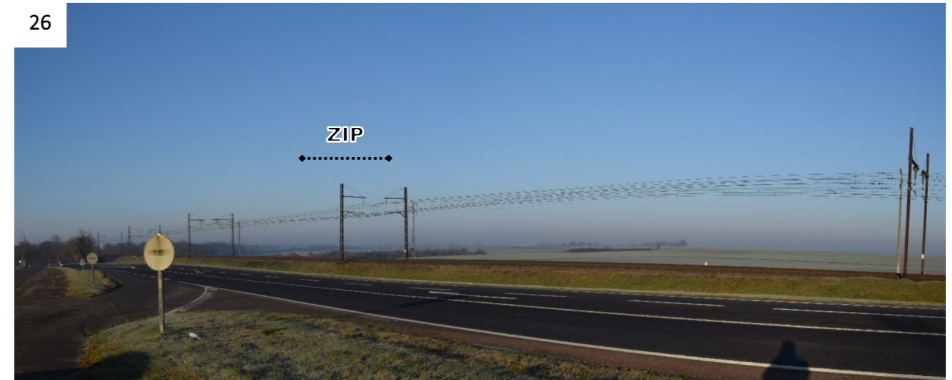
Figure 46 : La D2152 et la ligne de chemin de fer Blois-Orléans au niveau de Saint-Denis-sur-Loire (© ATER Environnement, 2023)
