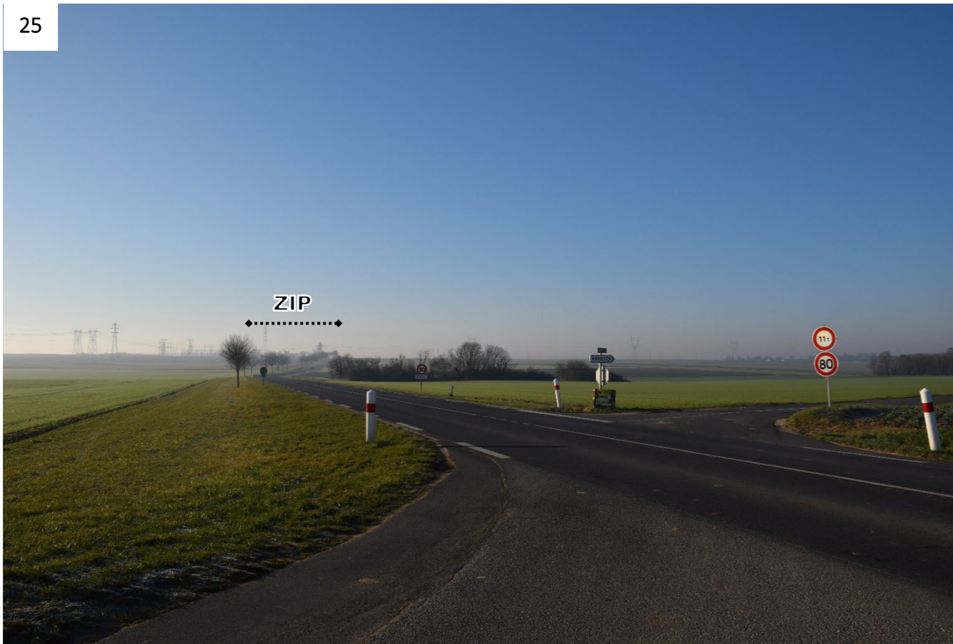
Figure 45 : La D924 en direction de Villebarou avec le poste électrique sur la gauche de l'arrière-plan (© ATER Environnement, 2023)
