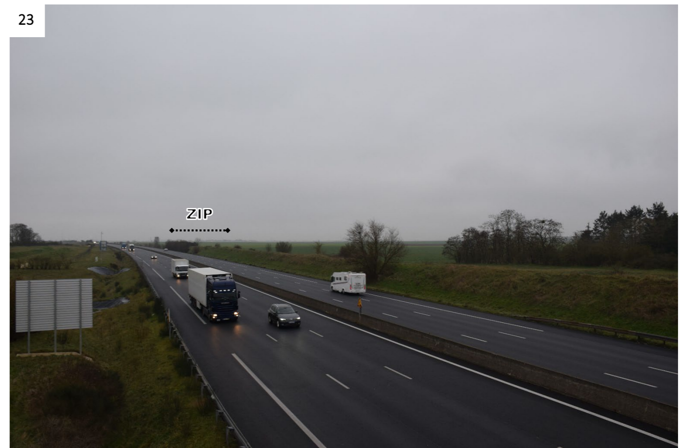
Figure 43 : La section nord-est de l'A10 (© ATER Environnement, 2023)
