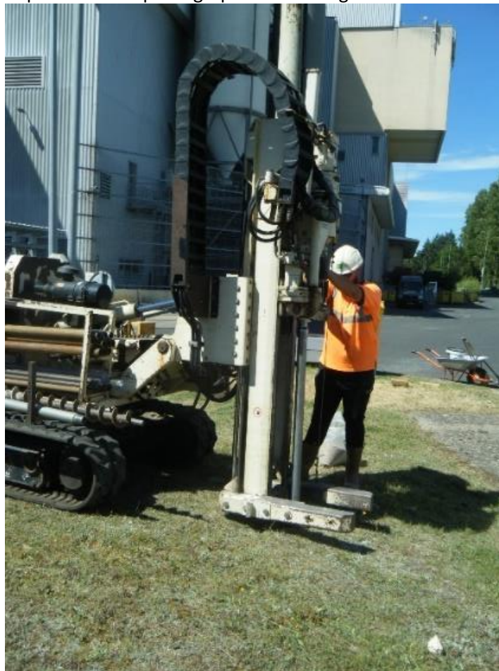
Figure 15 : Photographie du sondage S5
