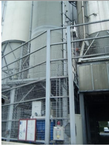
Silos de refiom /coke lignite/ chaux
