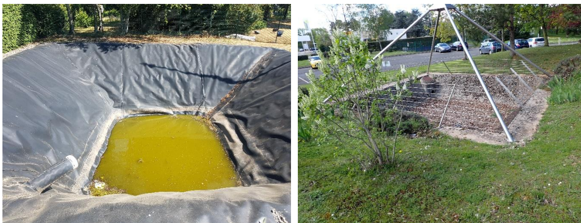
Photos 5 et 6 : Bassins de décantation
