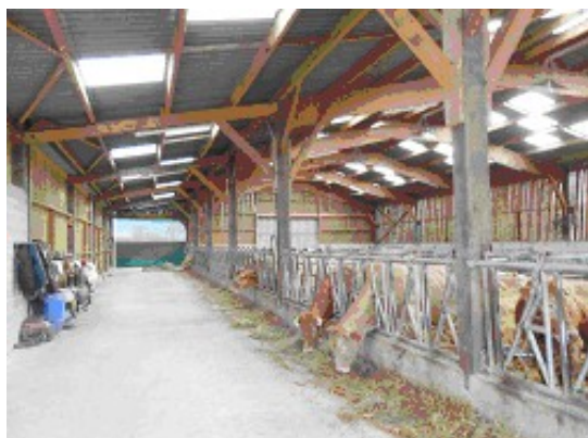
Construction d'un bâtiment de logement de bovins allaitants en bois (charpente et bardage) – PMBE Axe 1
